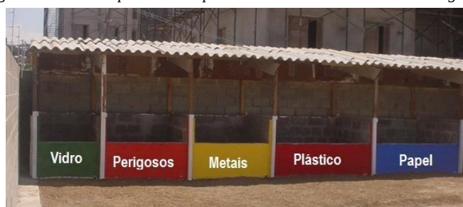
Figura 3.2-3: Exemplo de local para armazenamento de resíduos a granel
