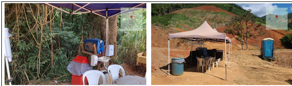
Figura 2.4-8: Lavatório e instalações sanitárias do Centro de vivência nas frentes de obra
