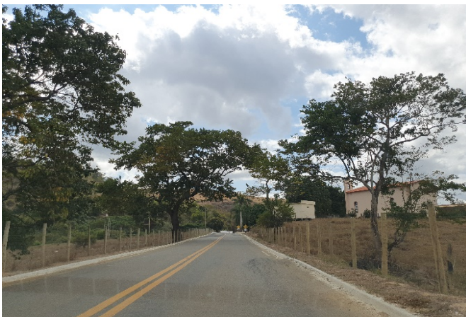
Figura 36 - Imagem rodovia e comunidade
