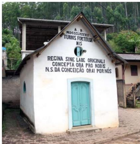
Figura 48 – Capela de Nossa Senhora da Conceição
