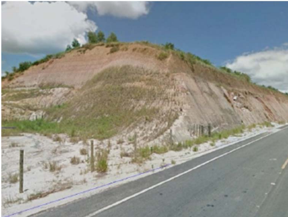
Foto 5 – Talude onde será implantada a Jazida 01
