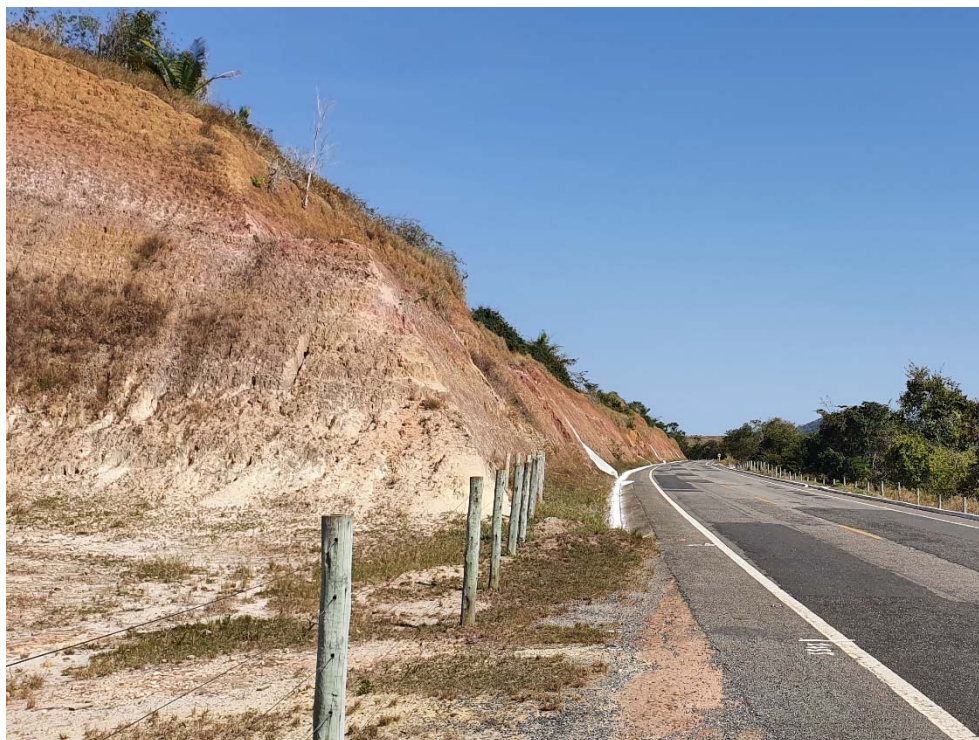
Foto 4 – Vista de grande corte junto a Rodovia ES-248, onde será implantada a Jazida 01
