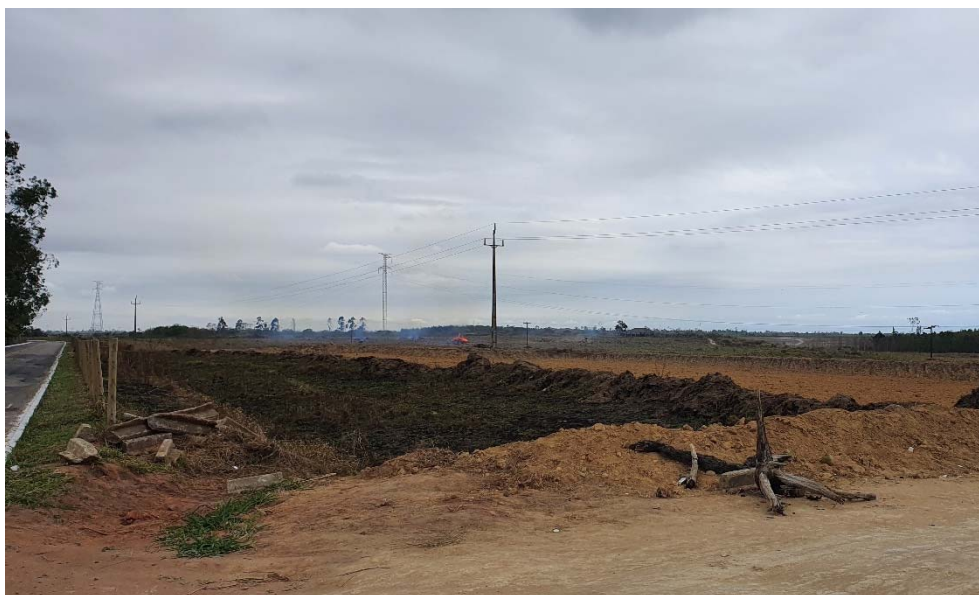
Foto 17 – Área a ser Utilizada como Canteiro, junto da ES-245 – Segmento 4
