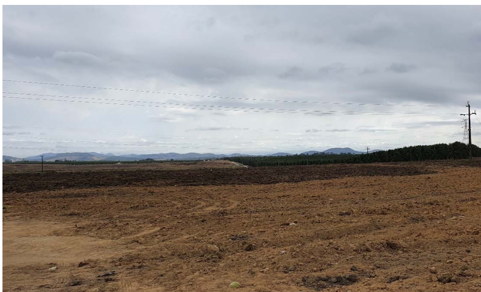
Foto 18 – Local onde será Implantado o Canteiro de Obras
