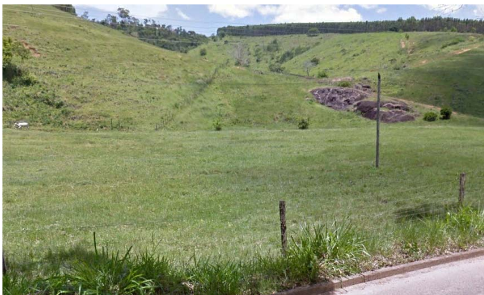
Foto 12 – Área onde será Implantado o Bota-fora 5
