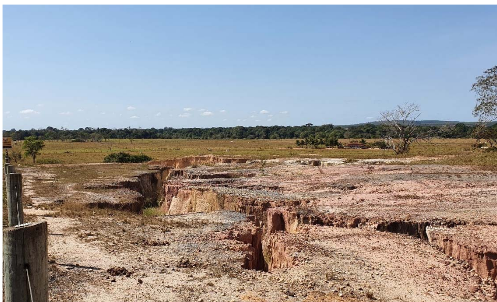
Foto 8 – Processo Erosivo que será Remediado com a Implantação do Bota-fora 01
