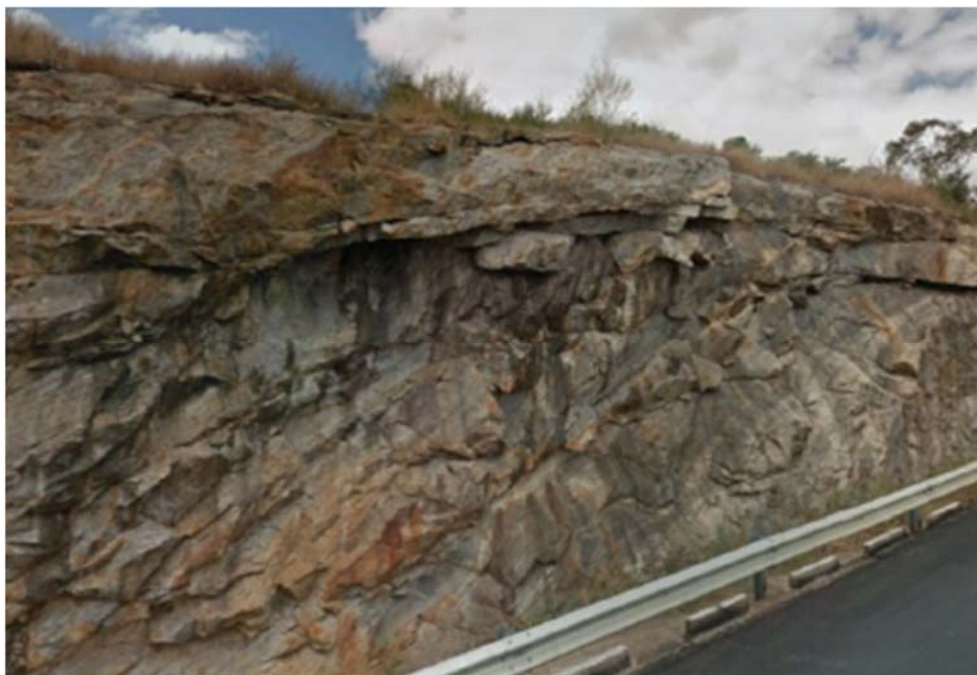
Foto 21 – Rocha Fraturada – Estaca 212 a 213 – ES 248 (Lado Esquerdo)
