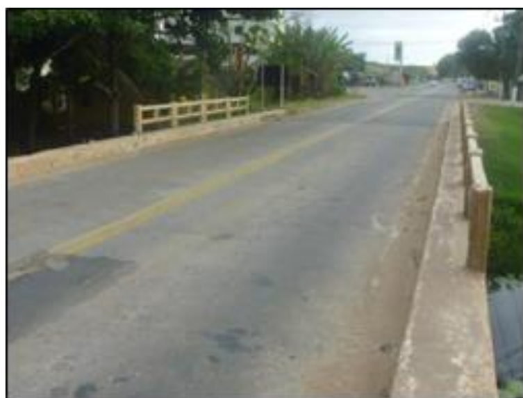
Foto 5 – Ponte sobre o córrego Guaxindiba.
