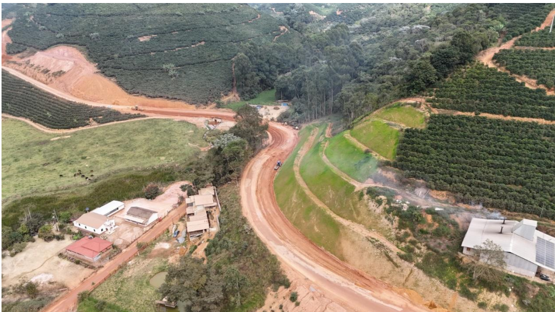
Imagem: Arquivo - Obra da Rodovia ES-379: Entr. BR-262 (Irupi) - Entr. ES-185 (Lúna)
