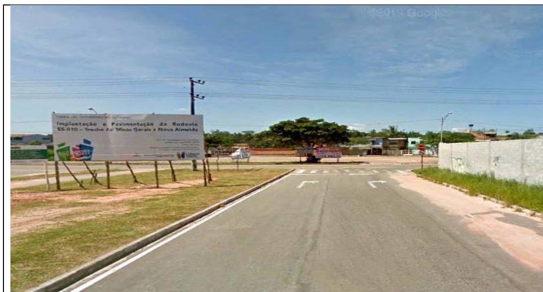
Fig. 7: Imagem início do Trecho 4 - Chegada da Rodovia Contorno de Jacaraípe no trevo de onde continuarão as obras: rua Homero Massena, rua Av. Hilário Sonegheti e Av. São Paulo.
