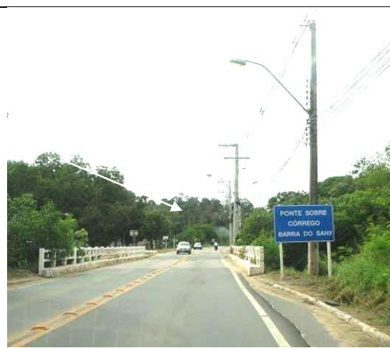
Fig 2. Ponte sobre o Córrego Sahy em Barra do Sahy.
