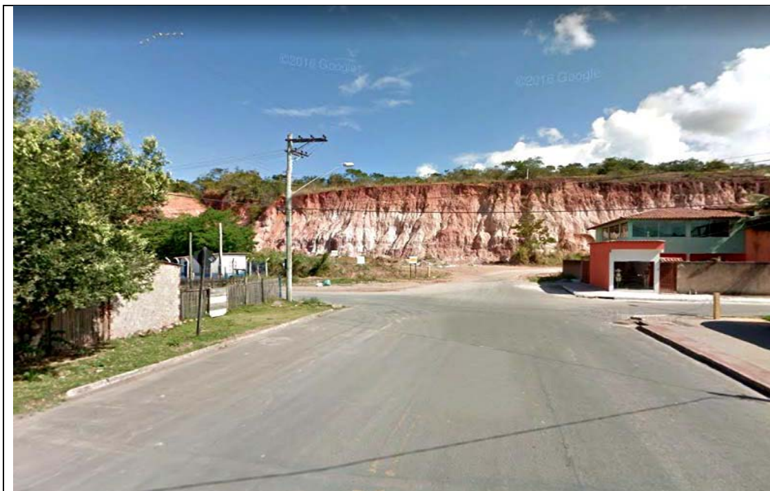
Fig. 8 : Imagem final do Trecho 4 - Final da Av. Belo Horizonte - Serramar - Nova Almeida. Ao fundo o talude por onde passará a continuidade da obra.
