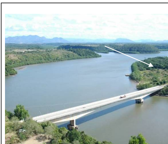
Fig. 1. Ponte José Ferreira Lamego sobre o rio Piraqueaçu em Santa Cruz.
