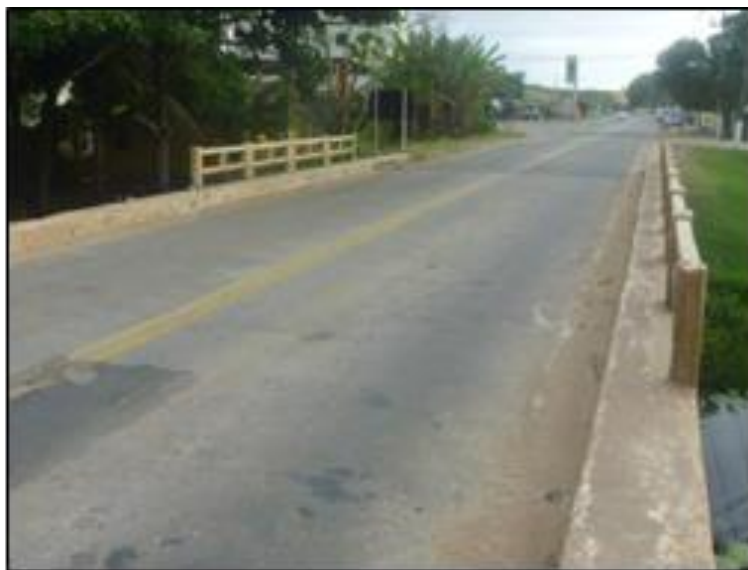
Foto 5 – Ponte sobre o córrego Guaxindiba.
