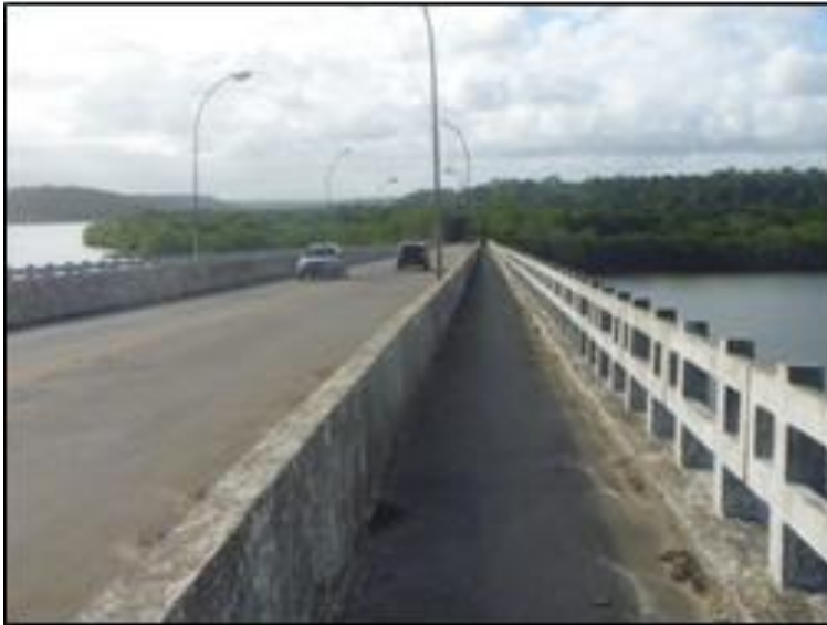
Foto 4 – Ponte sobre o rio Piraque- açú.
