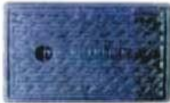
Fig 07. Hidrante de Recalque - Tampa.
